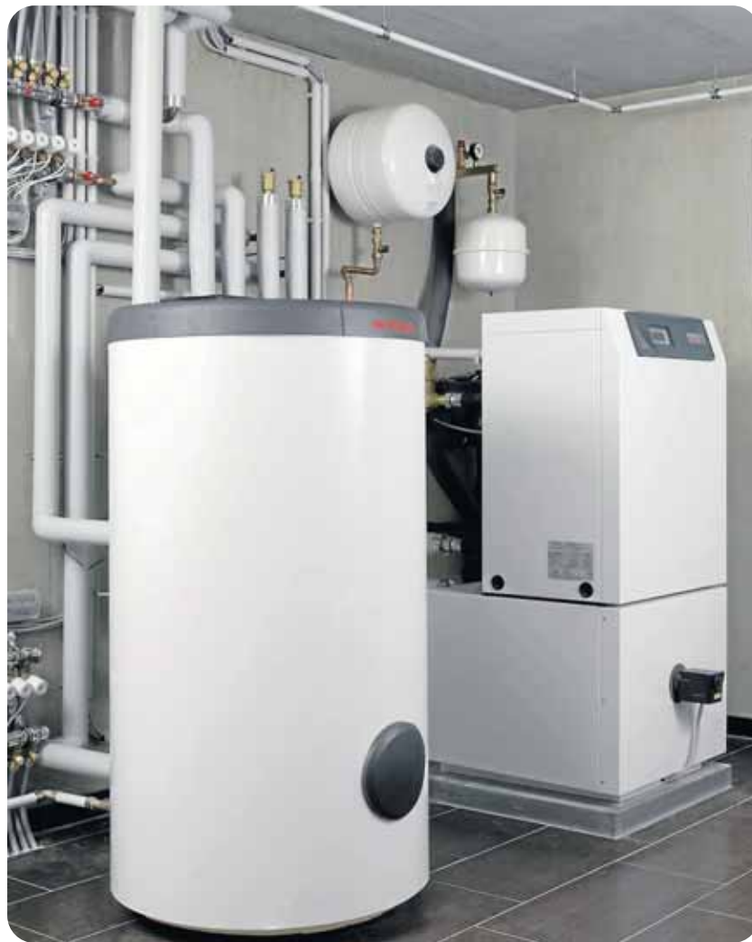
Finden Platz in Keller oder Hauswirtschaftsraum: Die Wärmepumpe mit einem Warmwasserspeicher. Foto Weishaupt
